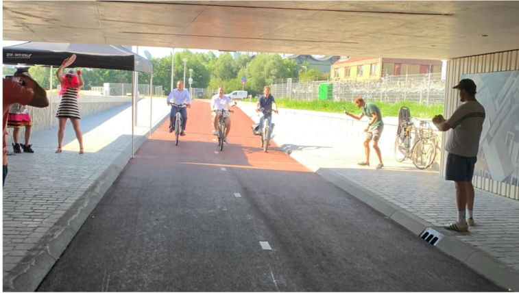
Het fietstunneltje onder de Mercuriusweg © Gemeente Den Haag
