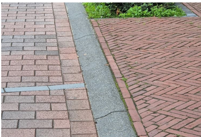
Vergevingsgezinde trottoirband (Houttuinen)
