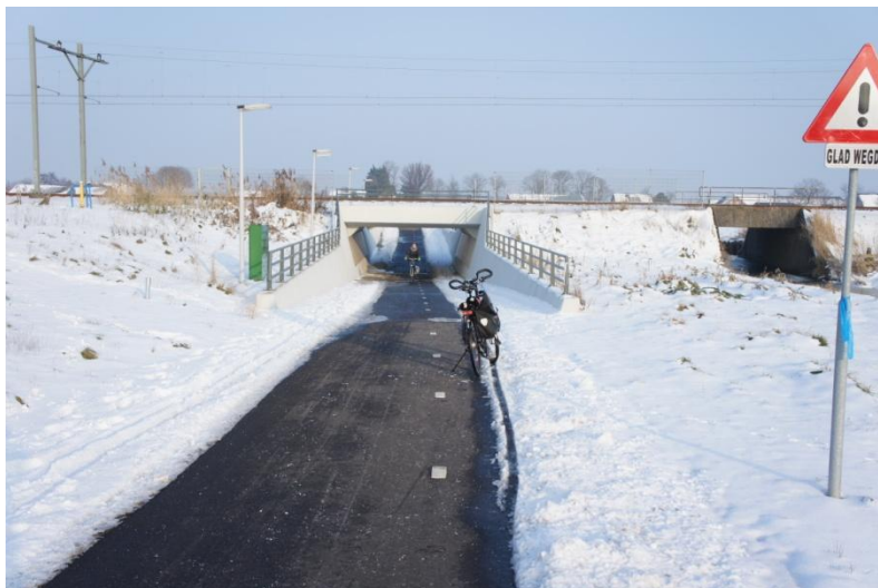
Foto 3. Fietster vermijdt de gevormde ijsplaat in de tunnel en er staat een waarschuwingsbord voor "glad wegdek".
