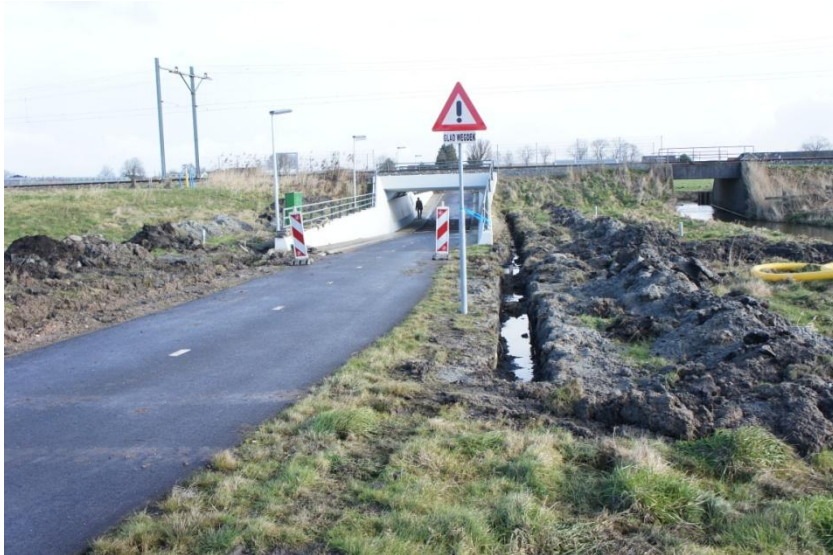
Foto 4. Opname op 7 februari 2013 aan de westkant van de tunnel.
