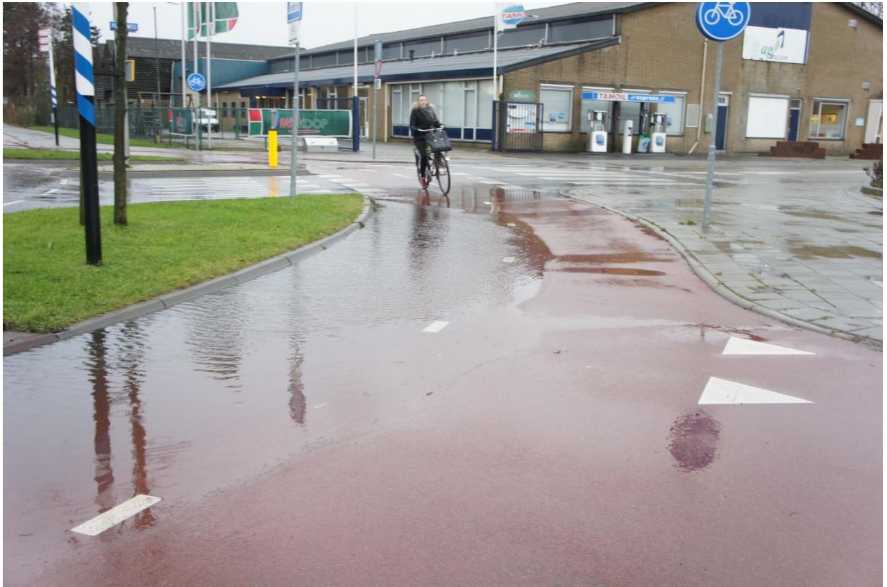
Figuur 4 Wateroverlast rotonde Europalaan: fietspad gereduceerd tot de helft
